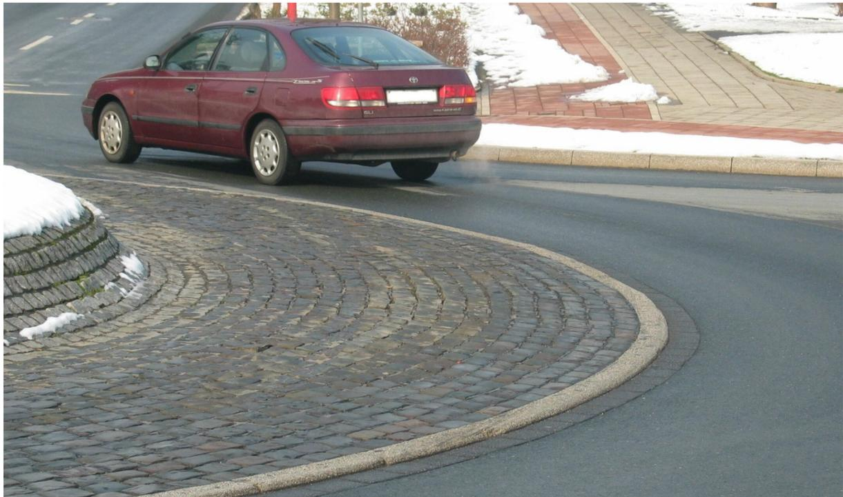
Abb. 23: Innenring als Natur-Pflasterfläche, Randeinfassung des Innenrings durch Rundborde
