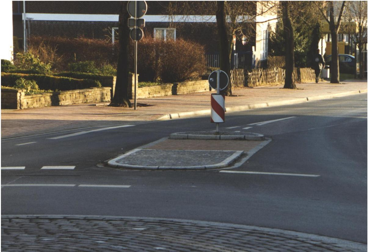
Abb. 7: Teilweise überfahrbarer Fahrbahnteiler
