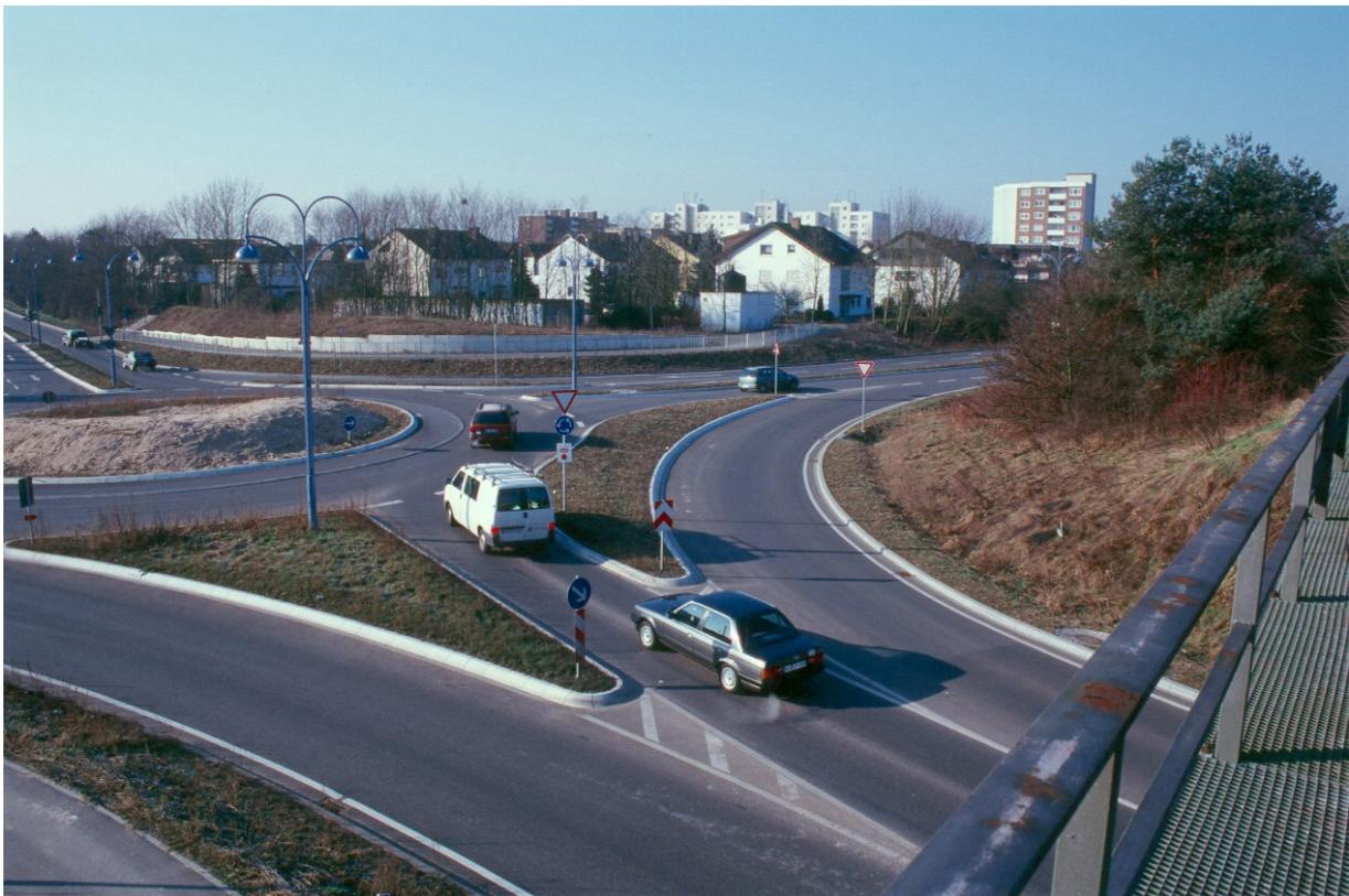
Abb. 5: Bypassfahrstreifen
