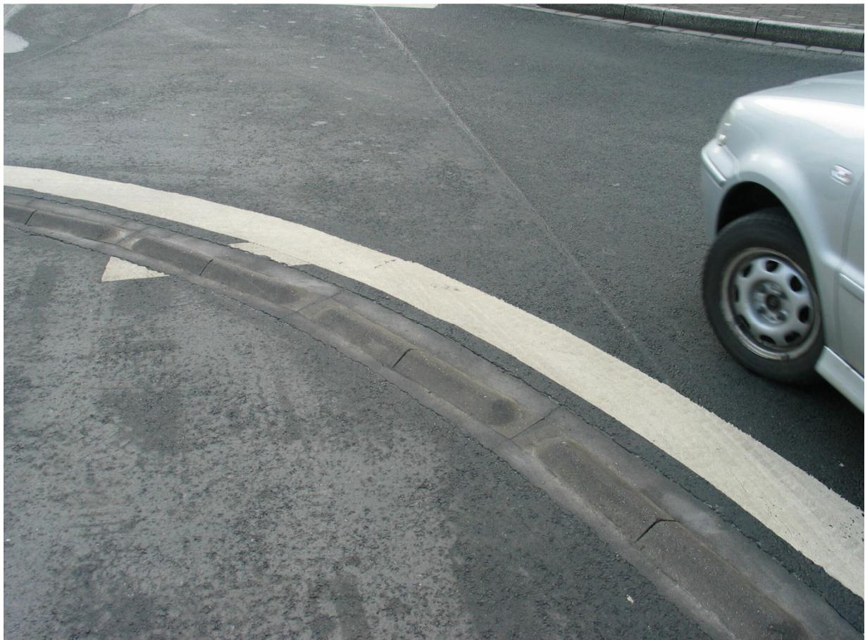
Abb. 13: Kostengünstiger Umbau zu Mini-Kreisverkehr: die Kreisinsel ist die frühere Fahrbahnoberfläche, Randeinfassung durch Beton-Leitelemente
