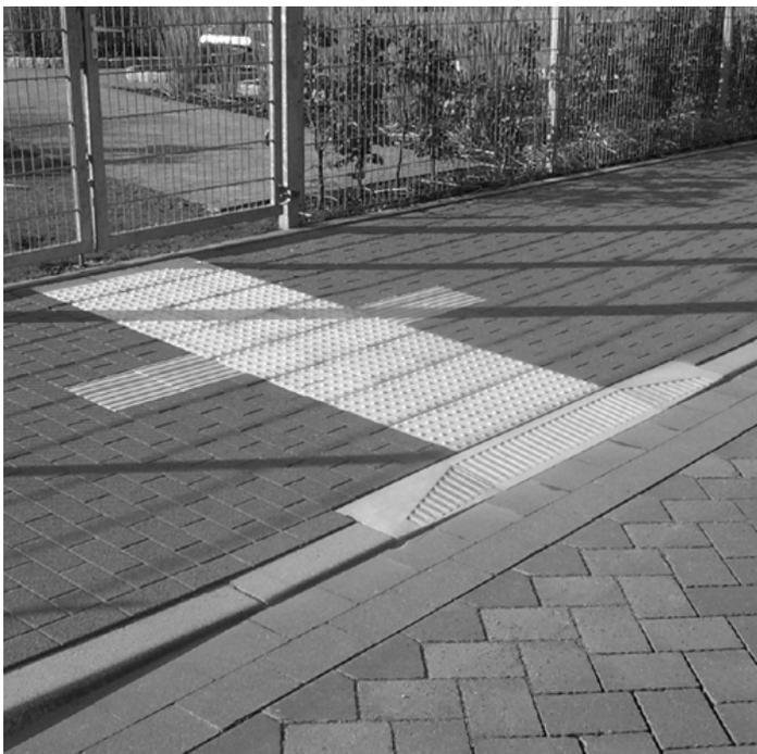
Abb. 16: Übergang von Gehweg zu Fahrbahn durch taktile wahrnehmbares Bord mit „Nullabsenkung“
