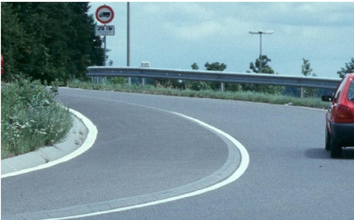
Abb. 21: Innenring in Asphalt-Bauweise, Randeinfassung des Innenrings und der Kreisinsel durch Flachborde
