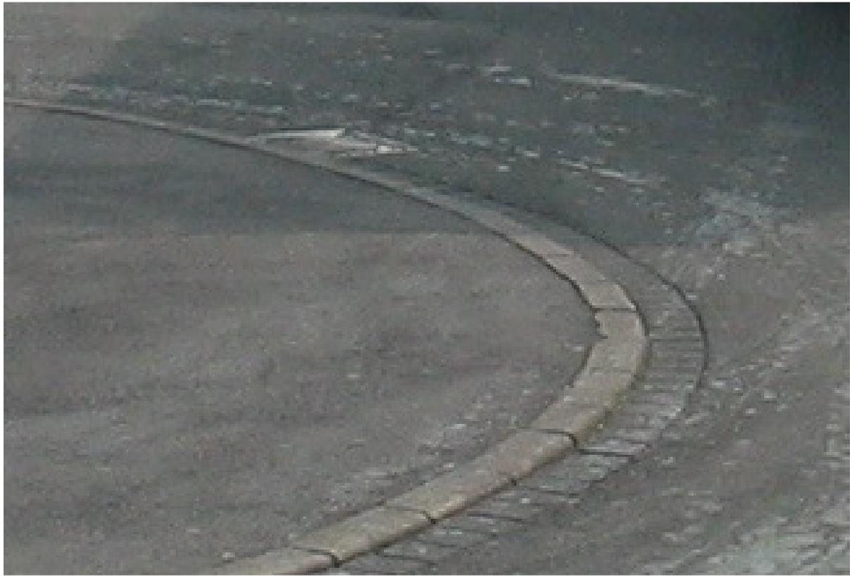
Abb. 22: Innenring in Asphalt-Bauweise, Randeinfassung des Innenrings durch Rundborde
