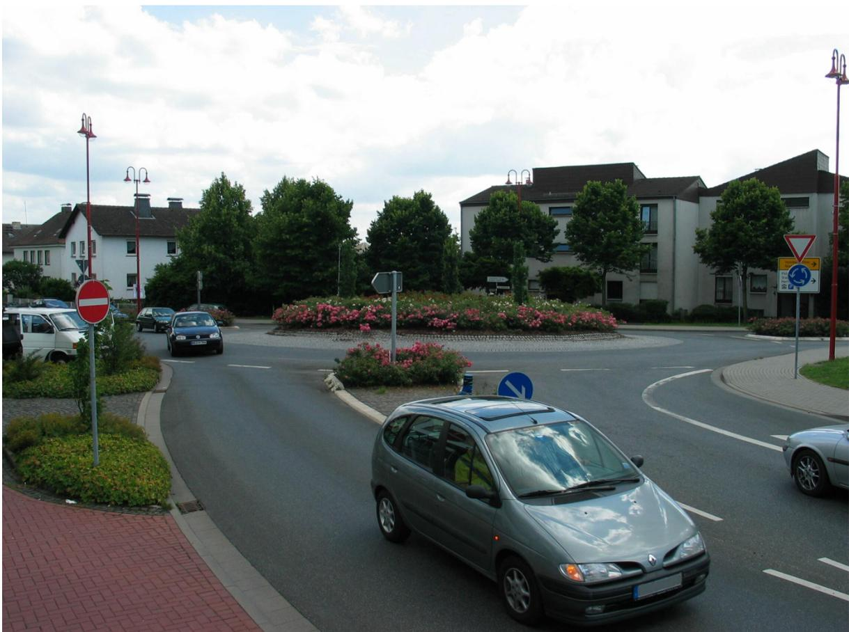
Abb. 1: Kleiner 1-streifiger Kreisverkehr mit Innenring
