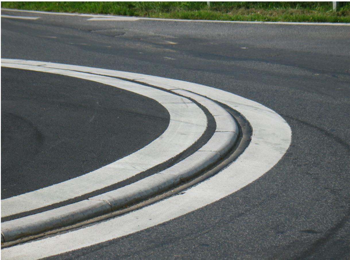
Abb. 11: Kreisinsel in Asphalt-Bauweise, Randeinfassung durch Rundborde
