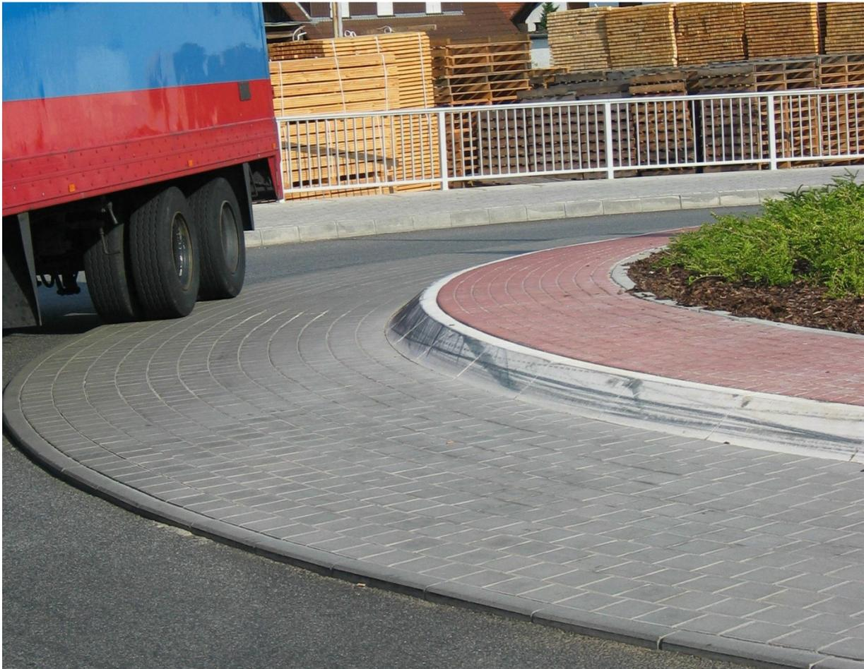
Abb. 20: Innenring als Betonpflasterfläche, Randeinfassung des Innenrings durch Rundbord, Randeinfassung der Kreisinsel durch Flachbord
