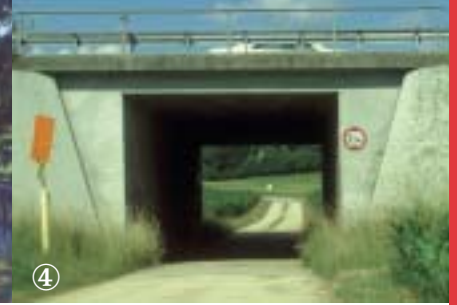
Oben: Schlechte Lösungen. Bild 3 und 4: »normale« Über- oder Unterführungen von Wirtschaftswegen oder Straßen, weil sie aus purem Asphalt oder Beton und außerdem viel zu schmal und zu dunkel sind.
