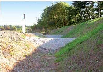
Versickerungsmulde kurz nach dem Bau
