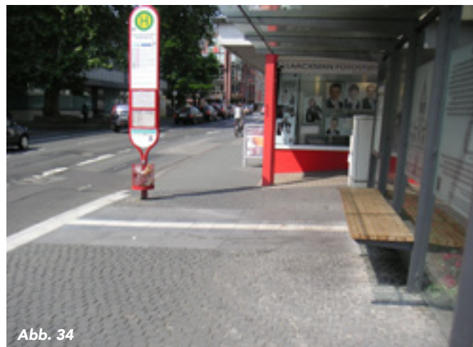
Abb. 34: Bushaltestelle in Marburg. Der Auffindestreifen zur Haltestelle besteht aus einer hellen Plattenreihe mit Rippen in der Mitte und zwei dunklen Plattenreihen außen. Dadurch ist ein visueller Kontrast gegeben. Der taktile Begleitstreifen hat eine ähnliche Färbung wie das umgebende Pflaster und nimmt sich optisch zurück. So ist der Auffindestreifen zwar deutlich sichtbar, aber nicht so dominant wie ein breiter weißer Streifen.
