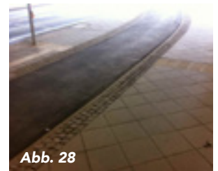
Abb. 26, 27 und 28: Trennstreifen in Liederbach, Mainz, Frankfurt (Grobpflaster und Trennstein). Der taktile und visuelle Kontrast muss gewährleistet sein. Auffindestreifen enden vor dem Trennstreifen. (Quelle Abb. 27: Ralf Keipinger, Mainz)
