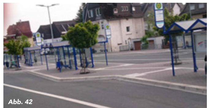
Abb. 41 und 42: S-Bahnhof in Frankfurt und Busbahnhof in Herborn. Die Abzweigfelder sind exzentrisch angeordnet. Die Bodenindikatoren sind je nach Umgebungsbelag hell oder dunkel.
