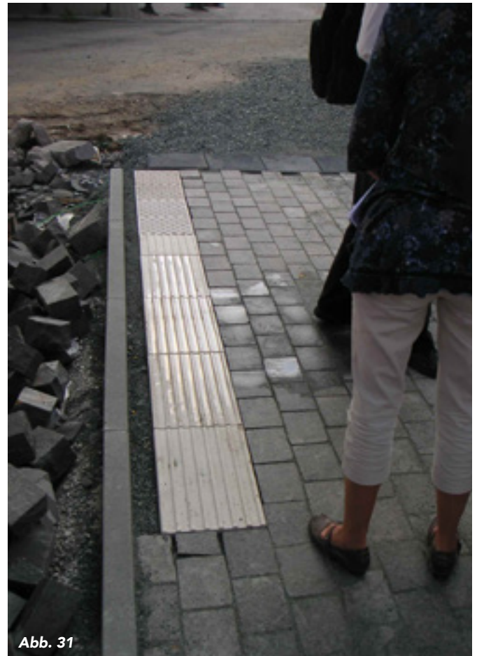
Abb. 31: Testbegehung eines Basaltbelages (gebrochen, geflammt) in Frankfurt-Höchst. Den Rollstuhlfahrern war die Berollbarkeit ausreichend, blinde und sehbehinderte Menschen konnten die Bodenindikatoren hier gut erkennen. Bei Verwendung von Naturstein sollte vorher immer ein Test durchgeführt werden.
