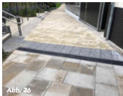
Abb. 36: Auffindestreifen für seitliche Treppen in Raunheim. Die Fahrradständer sind durch die Anrampung mit dem Langstock tastbar von der Gehbahn getrennt.
