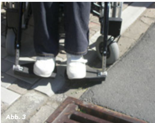
Abb. 3: An Engstellen müssen Borde oft überschritten werden, um die Fahrbahn mit zu benutzen. Zudem müssen sie dann oft noch schräg gequert werden. Deshalb ist eine weiche Separation (siehe Kap. 2.6 und RAS 5.2.5) in solchen Fällen die bessere Lösung.
