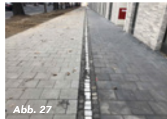
Abb. 26, 27 und 28: Trennstreifen in Liederbach, Mainz, Frankfurt (Grobpflaster und Trennstein). Der taktile und visuelle Kontrast muss gewährleistet sein. Auffindestreifen enden vor dem Trennstreifen. (Quelle Abb. 27: Ralf Keipinger, Mainz)
