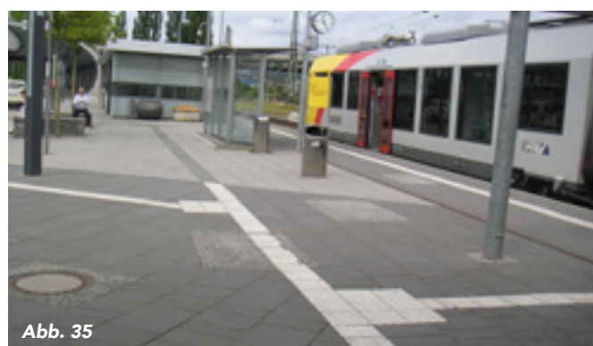
Abb. 35: Wetzlar. Je nach Umgebungsbelag werden helle und dunkle Bodenindikatoren verlegt.
