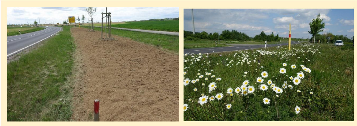
Abb. 7 Beispiel einer Neueinsaat auf einer nachträglich aufgewerteten Fläche an der L3057 bei Friedrichsdorf, Konzept für eine Steigerung der Biodiversität von Flora und Fauna auf den Straßenbegleitflächen in Hessen, Quelle: Hessen Mobil, November 2021
