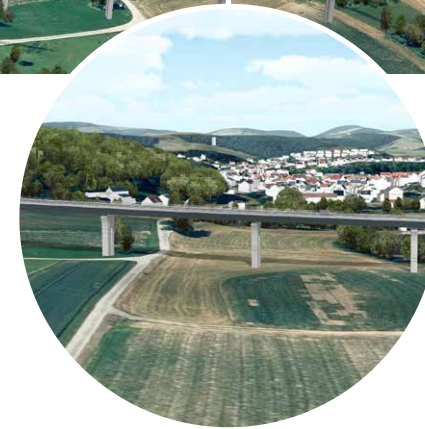
Talbrücke Mörlenbach Länge: 300 Meter
