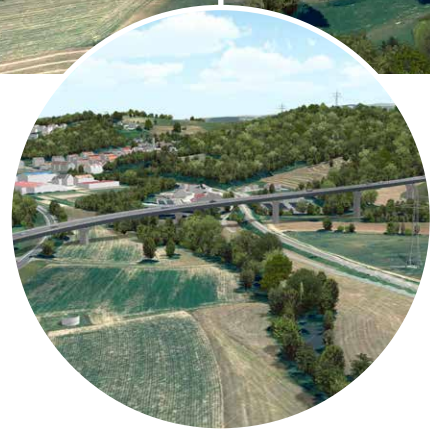
Talbrücke Reisen Länge: 400 Meter
