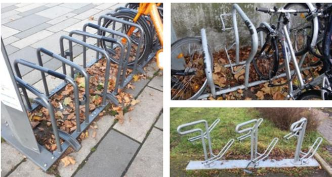
**Abb. 1:** Fahrradabstellanlage in tief/tief-Aufstellung (links), Fahrradabstellanlage in hoch/tief-Aufstellung (rechts oben), Fahrradabstellanlage in hoch/tief-Aufstellung über Bodenniveau (rechts unten)
