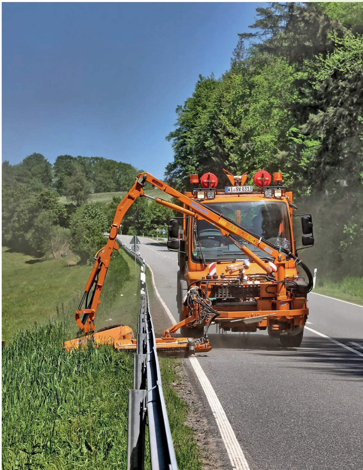
Abb. Nr. 27: Geräteträger mit Randstreifen- und Ausleger-Mulchgerät im Einsatz
