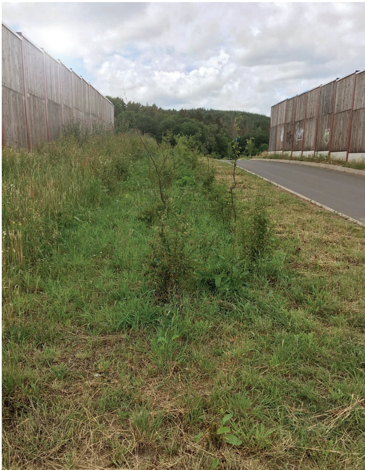
Abb. Nr. 46: Irritationsschutzwand und neu angelegte Leitpflanzung für Fledermäuse auf einer kombinierten Wildbrücke mit Wirtschaftsweg
