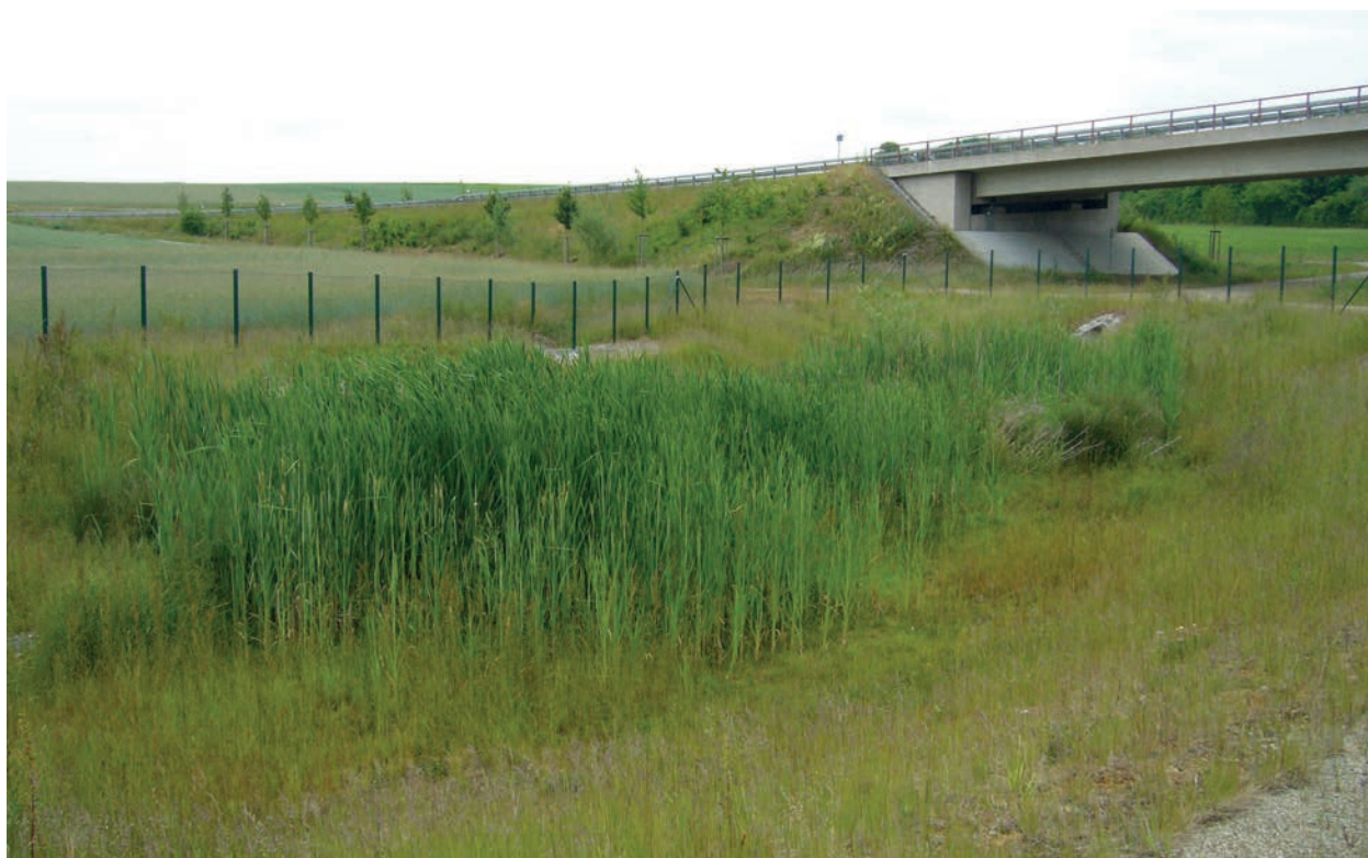
Abb. Nr. 44: Regenrückhaltebecken mit Röhricht an einer Bundesstraße
