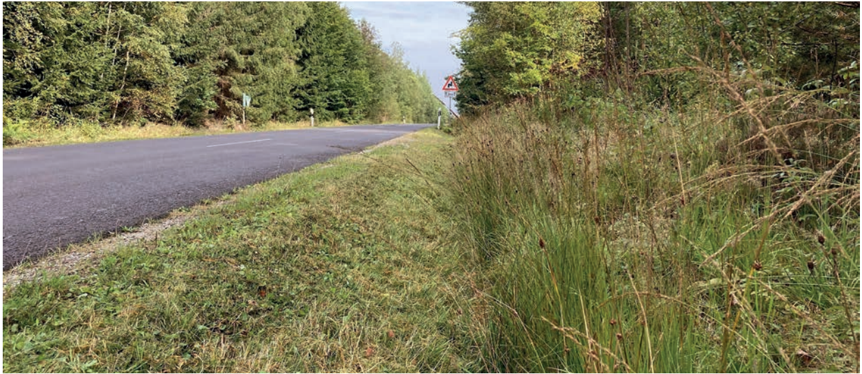
Abb. Nr. 7: Binsen in der Grabenzone mit gepflegtem Intensivbereich. Die Entwässerungsmulde ist in diesem Abschnitt noch nicht gemäht.
