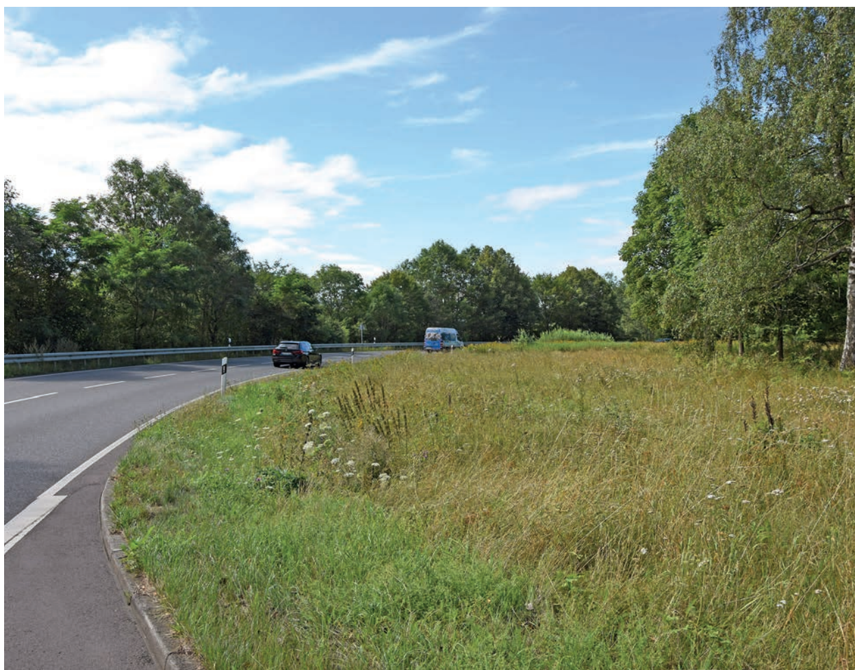
Abb. Nr. 1: Bundesstraße mit Verbindungsstrukturen von mehreren Metern Breite mit Wiesen- und Gehölzflächen
