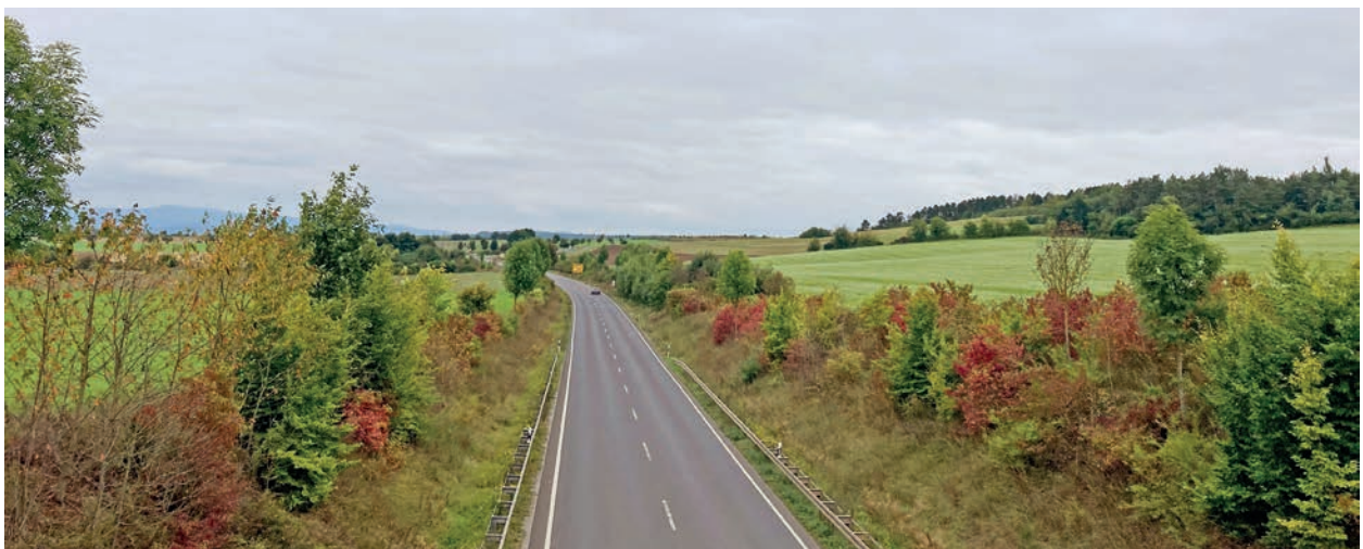
Abb. Nr. 12: Gebüschstreifen entlang einer Landesstraße
