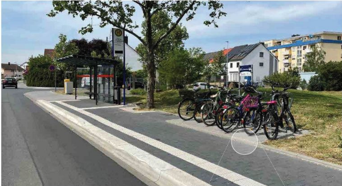
Abbildung 17: Tastkante als Warnung vor Fahrradabstellbügeln, wegen Stolpergefahr aus Gehbahn gerückt
