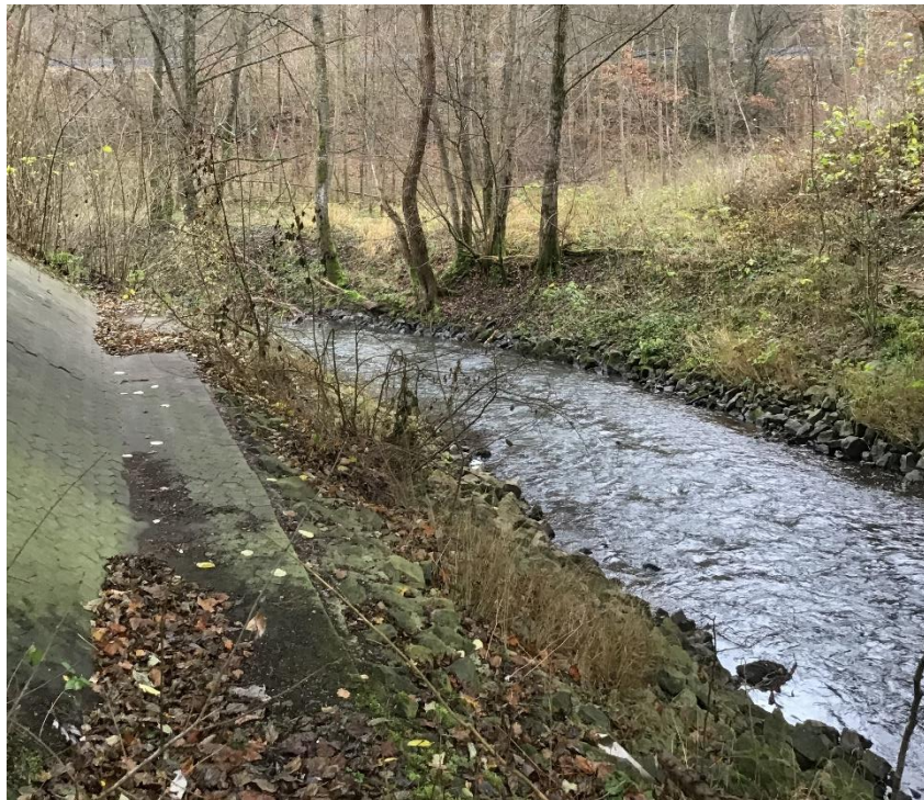
Versiegelter Untergrund der Brücke über die Haune.
