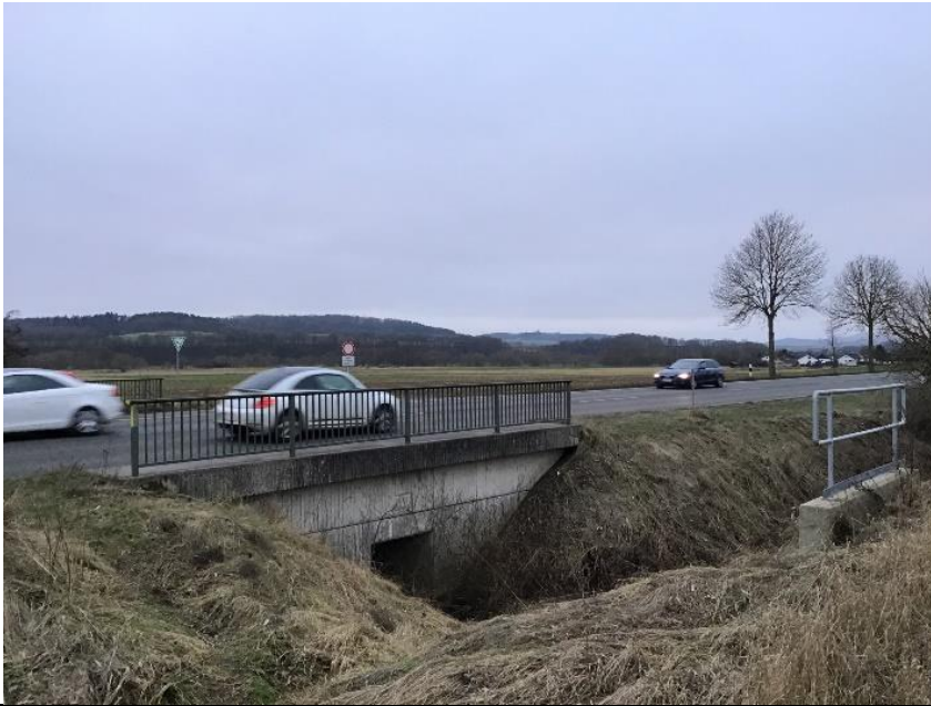
Unterführung des Salbach an der B 253.
