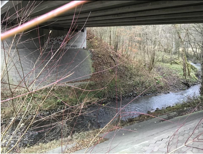
Brücke über die Haune (BW-Nr. 5324568).
