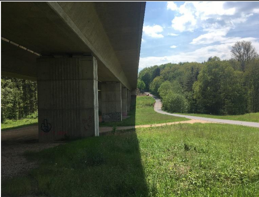
Tiefenbachtalbrücke Seite A und paralleler Wirtschaftsweg.
