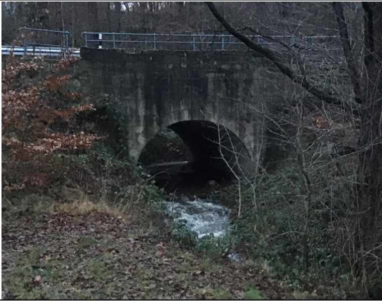
Unterführung des Rattbachs.
